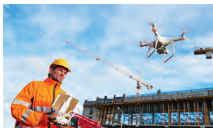
Verificarea cu drona a unei construcții
